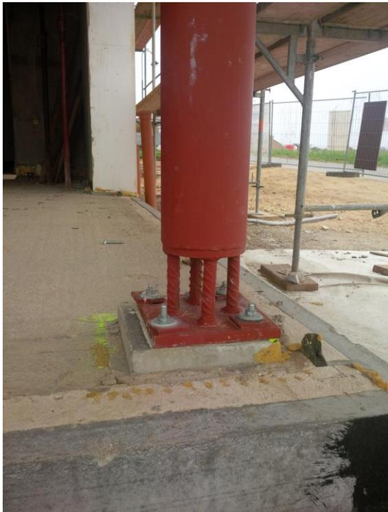
Coupure thermique pour colonnes métalliques
