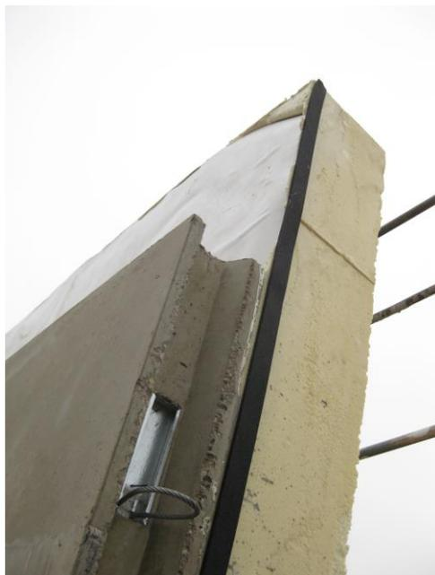
La fixation et le réglage des murs en pied de mur seront réalisés par des rails d'ancrage incorporés dans le voile en béton et fixés à la dalle ou à la fondation portante par l'intermédiaire de cornières métalliques et de chevilles.
