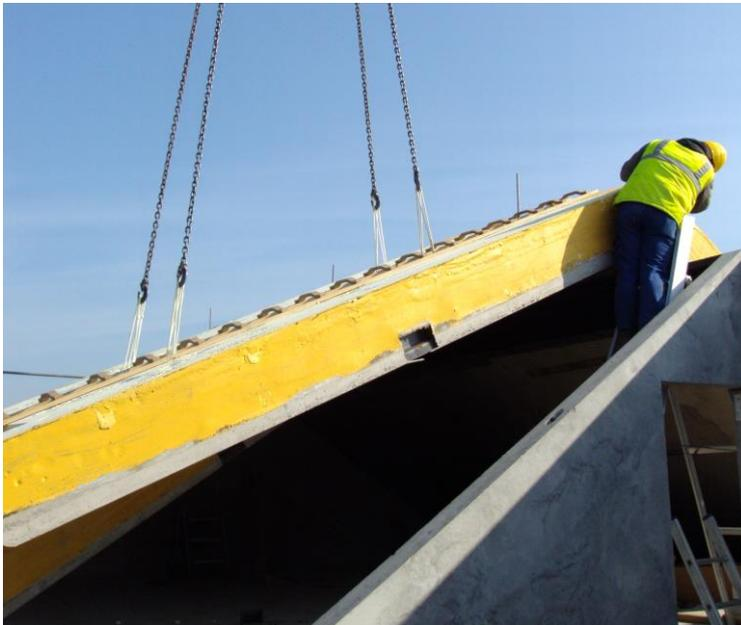
La réalisation de débordement de rives sera réalisée par une échelle de chevrons fixée dans les éléments de renforts incorporés dans les murs Pamaflex.
