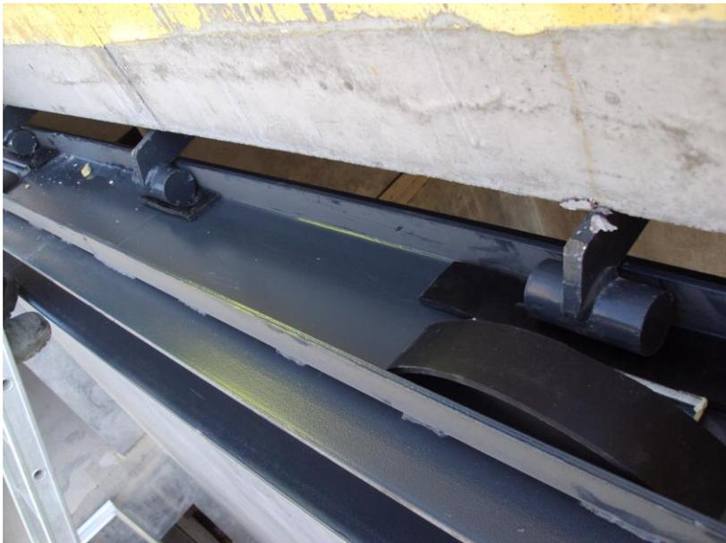
L'appui horizontal en bas de versant sera prévu dans l'élément de toiture avec une inclinaison de l'élément en béton qui s'adaptera sur le mur Pamaflex. L'élément de toiture reposera sur la tête du mur sur laquelle sera fixé préalablement un néoprène de minimum 10 cm de largeur.
