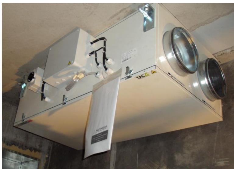
Le groupe de ventilation est muni de ventilateurs centrifuges à courant continu et possède le mode de fonctionnement à débit constant qui permet de maintenir le débit prescrit.
