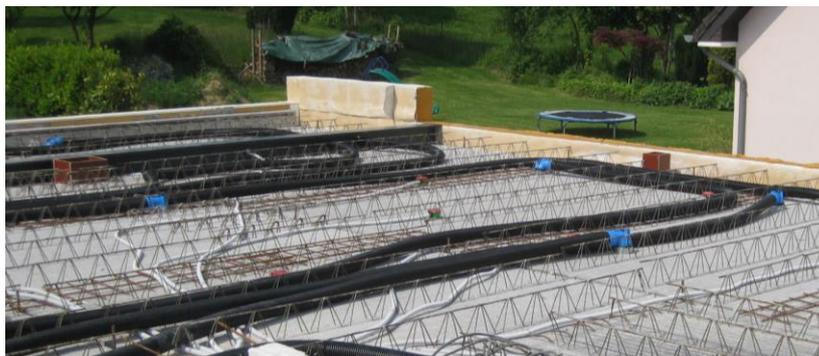
Le passage entre les gaines flexibles et les bouches de sorties de la maison est assurée par des coudes, qui sont calés sur chantier dans des ouvertures qui ont été prévues dans des prédalles.
